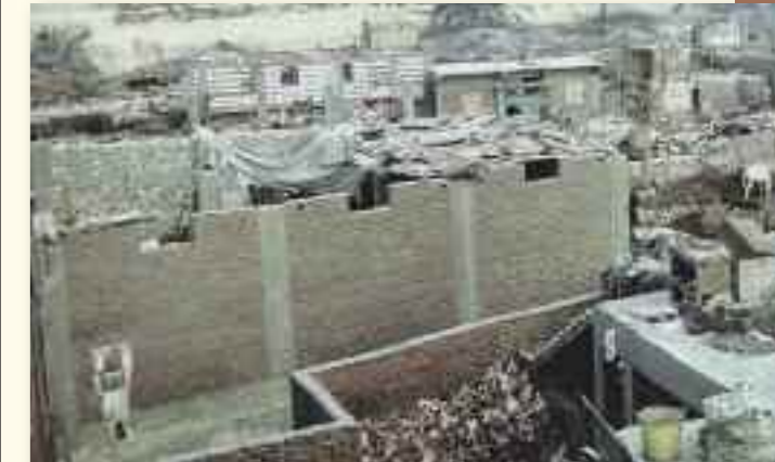
Les murs de briques remplacent les parois de tôle
